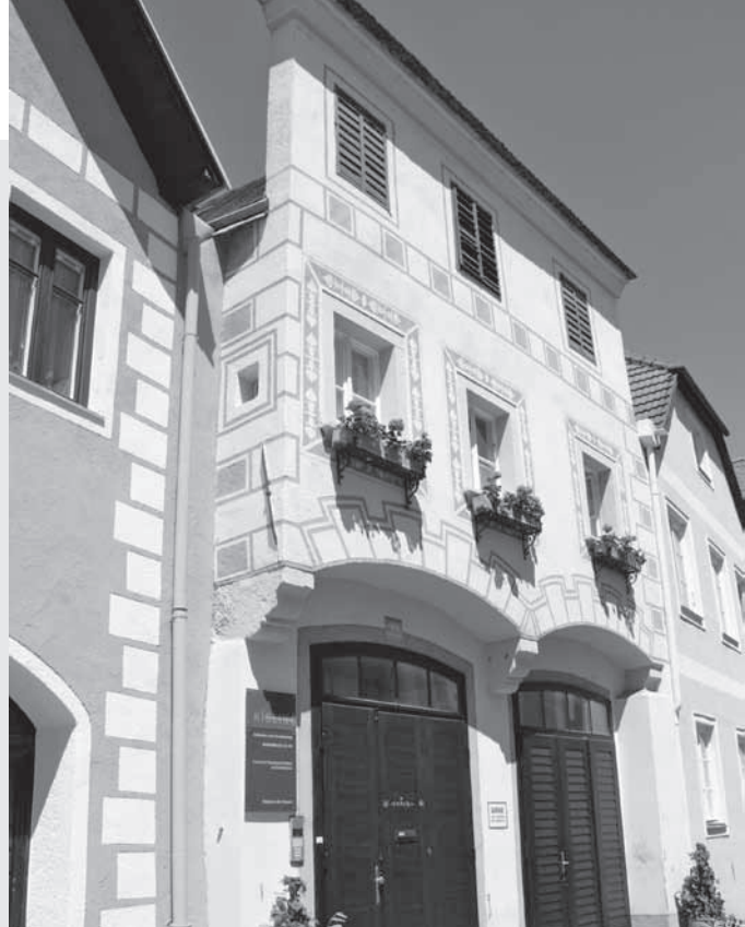
Dom na ulici Steiner Landstrasse s falošnou fasádou na 2. poschodí
